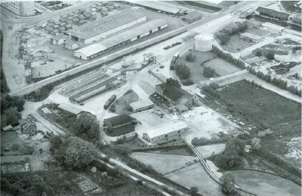
Kolding Saftstation 1957 /e/.
