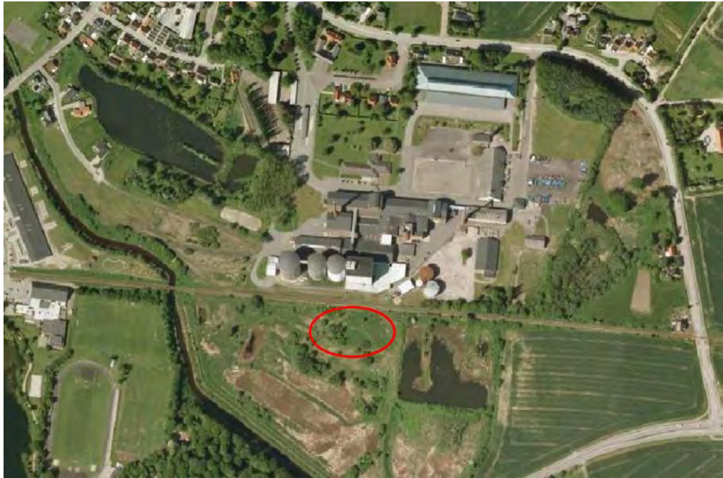
Figur 5.9 Del af jordbassin undersøgt i 1991 /30/. Undersøgelsesområdets formodede placering er markeret med rødt.
