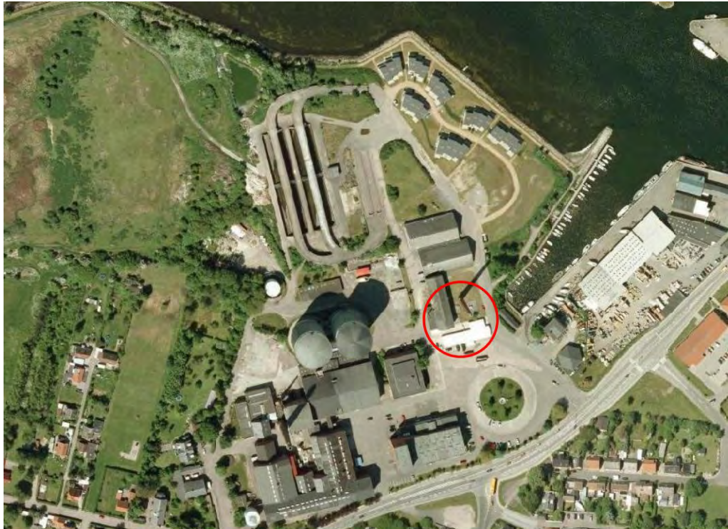
Figur 5.5 Del af opfyldt område undersøgt 1990-1991 /19/ og /20/. Undersøgelsesområdet er markeret med rødt.
