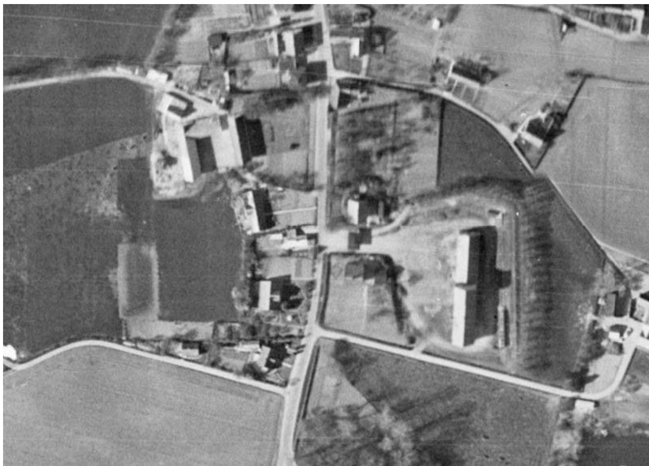
Damme Saftstation 1954 /c/.
